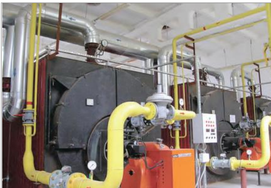
Рисунок 2 – Общий вид котельной
